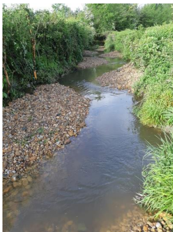
Restauration du lit
