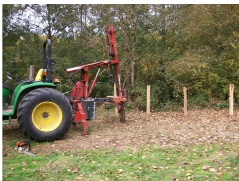
Aménagement d'une clôture
