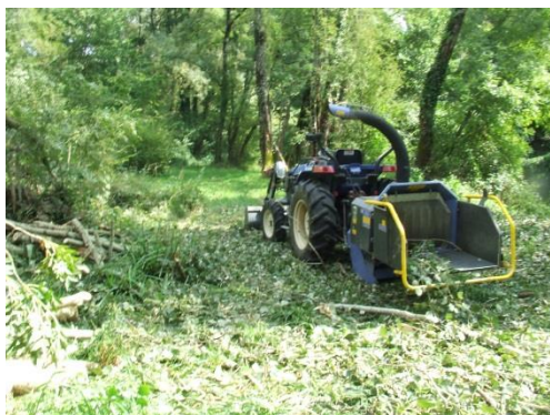
Restauration de ripisylve
