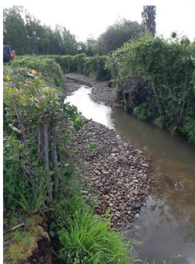
Restauration du lit
