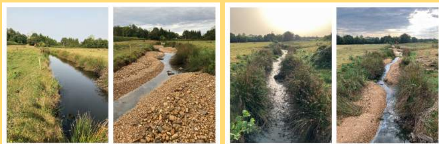
Travaux de recharge granulométrique sur l’Anglin amont
