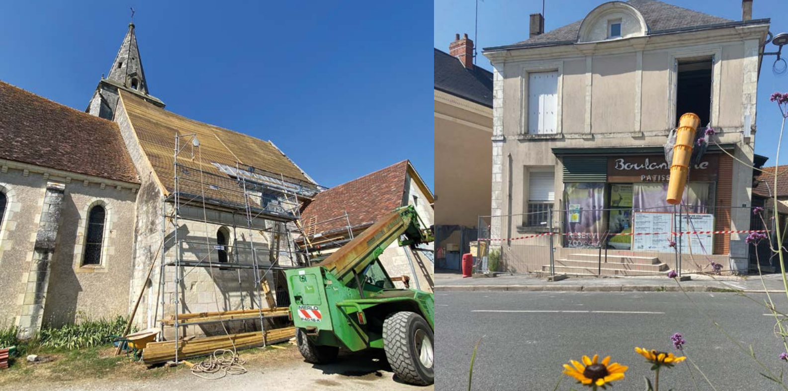
Les travaux du centre bourg
